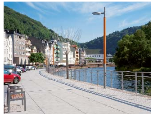
Page 79 RFL544 [S] LED Street and area lighting Strassenbeleuchtung Lenneufer. Altena (D)
