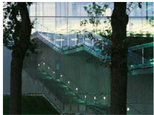
Page 45 TRO259 Wall luminaires/recessed Posttower Bonn (D)
