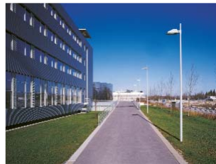
Page 103 PFL240 [S] 150 W HPS Street and area lighting Technische Universität Garching (D)
