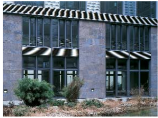
Page 44 QR1254 Wall luminaires/recessed Quartier am Salzufer Berlin (D)
